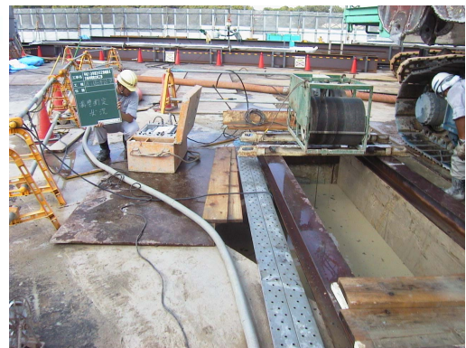
写真-1 超音波測定状況
