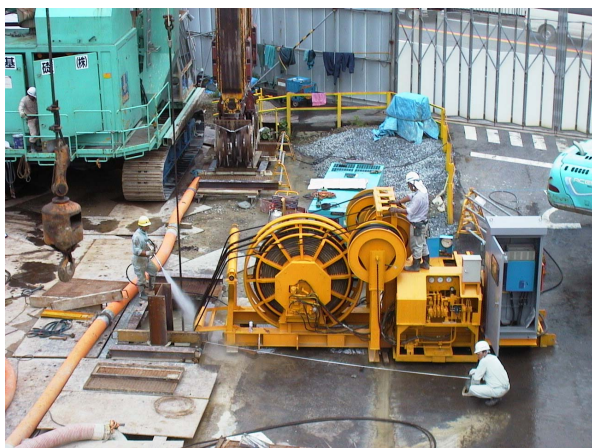
写真-6 すかし掘り部 掘削状況
