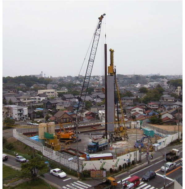
写真-3 SMW工法 芯材建込状況
