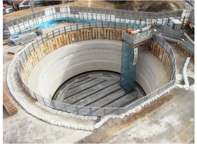
写真-8 現在の本体構築状況 (平成16年1月30日撮影)
