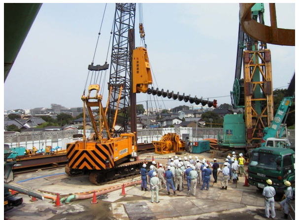
写真-5 地中連続壁・すかし掘り工 すかし掘り部掘削機
