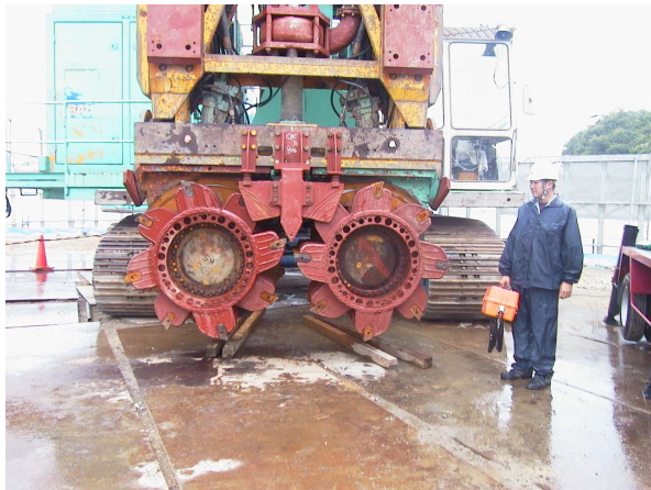
写真-4 地中連続壁・すかし掘り工 一般部掘削機
