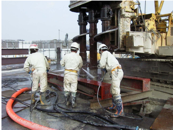
写真-2 SMW工法 掘削状況
