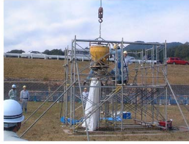
写真-2 浚渫土充填状況
