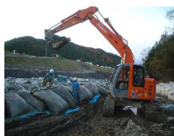
写真-7 土嚢荷下ろし用バックホウ
