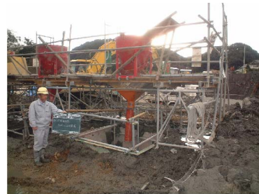
写真-5 仮設ステージ
