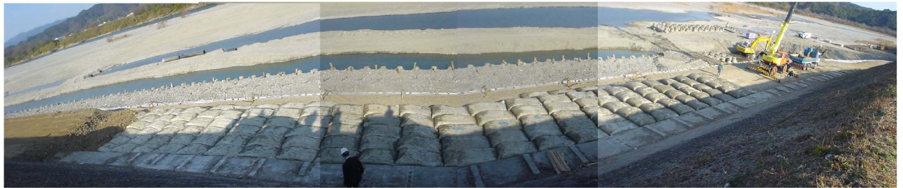
写真-11 堤体盛土施工状況全景
