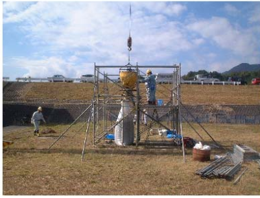
写真-1 事前施工設備全景
