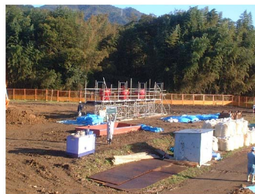
写真-4 仮設ステージ全景
