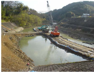
写真-9 浚渫状況
