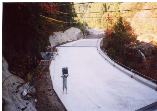
写真-2 終点側完了全景
