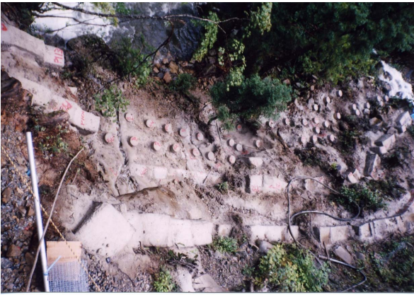
写真-4 基礎部設置完了
