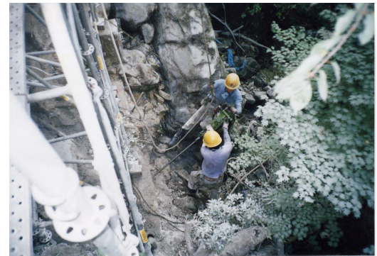
写真-7 ロックボルト打設状況
