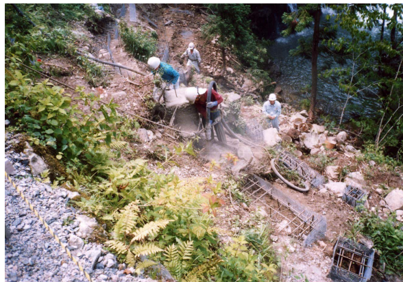
写真-3 基礎部吹付け状況
