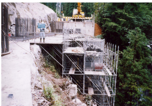
写真-5 支保工組立状況
