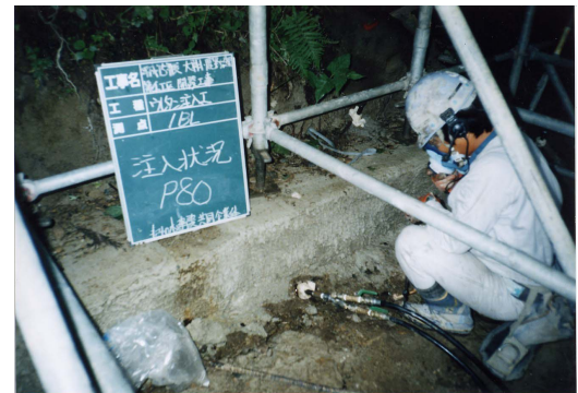
写真-6 薬液注入状況
