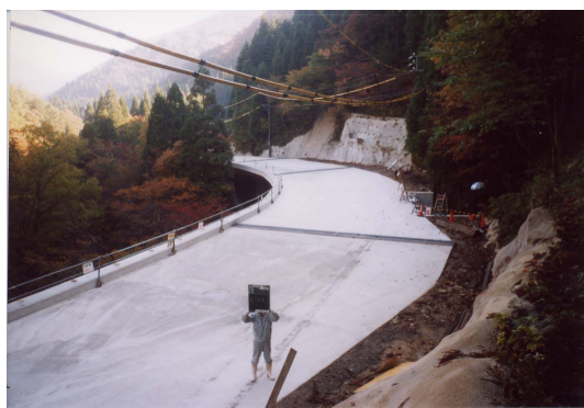
写真-1 始点側完了全景
