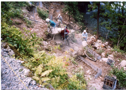
写真-3 基礎部吹付け状況
