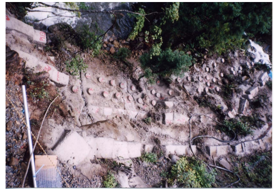
写真-4 基礎部設置完了
