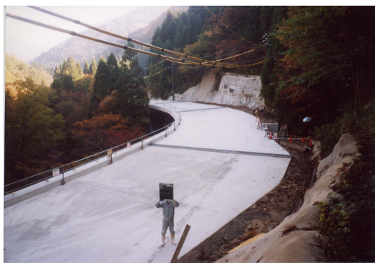
写真-1 始点側完了全景
