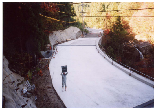
写真-2 終点側完了全景
