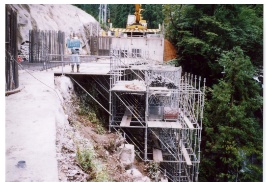
写真-5 支保工組立状況
