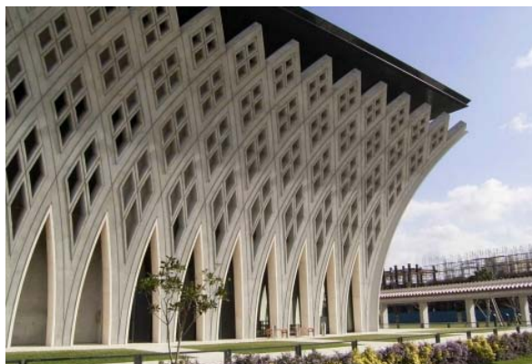
写真-2 PCa 外壁板
