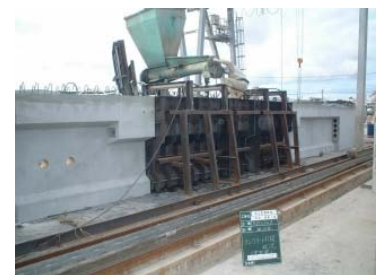
写真-19 PCa 大梁製作状況
