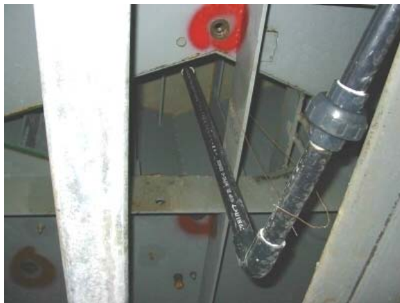
写真-8 型枠クーリング配管設備
