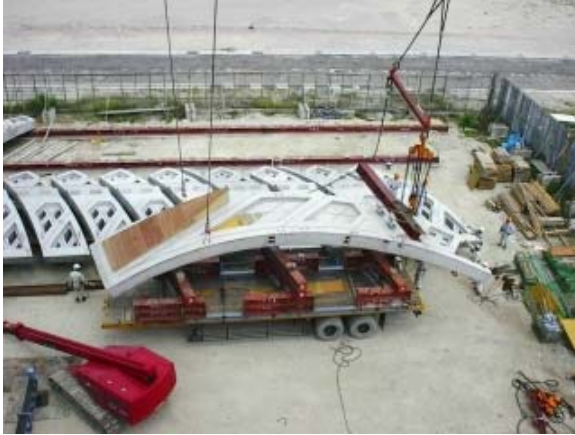
写真-12 地切状況
