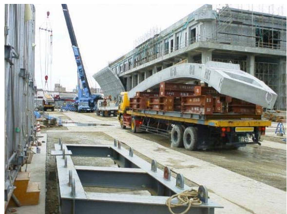
写真-11 場内運搬状況
