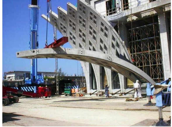
写真-13 建方状況
