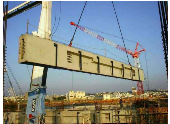
写真-22 PCa 大梁架設状況
