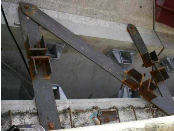
写真-14 仮設金物
