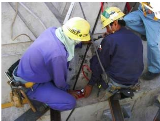
写真-17 目地型枠施工状況
