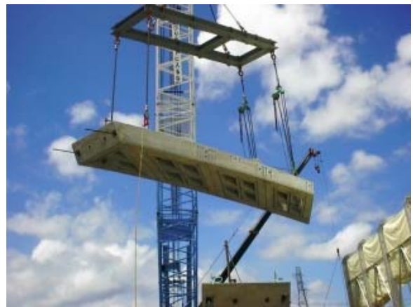
写真-9 脱型状況
