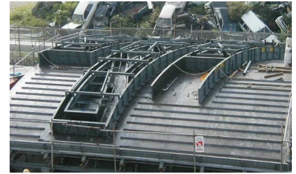
写真-6 鋼製型枠
