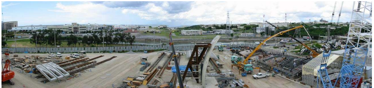
写真-5 製作ヤード全景
