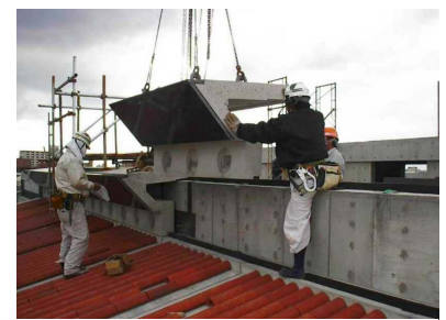
写真-27 パラペット版架設状況
