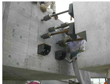
写真-24 PCa 片持ち梁接合部
