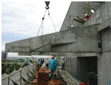
写真-23 PCa 片持ち梁架設状況
