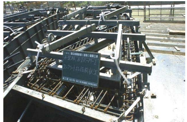
写真-7 打設前状況
