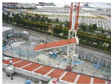
写真-26 庇版架設状況
