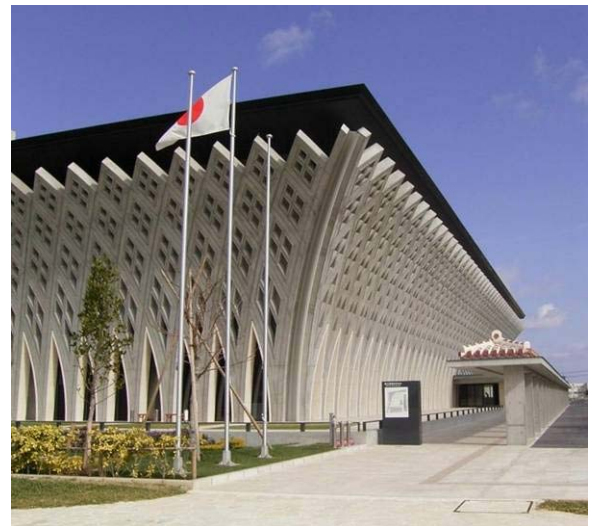
写真-1 建物外観
