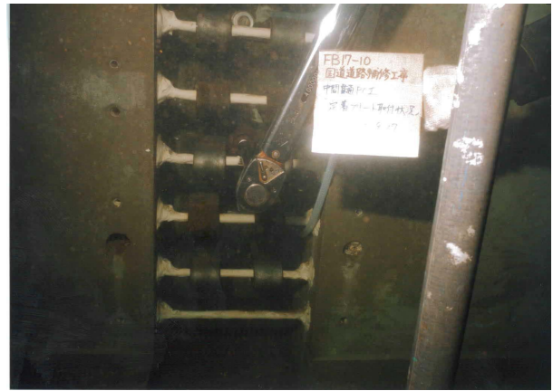
写真-1 トルクレンチによる緊張
