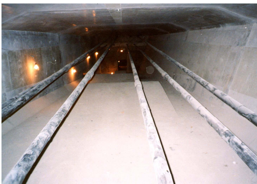
写真-1 上り線:セメントグラウト工法(左)と下り線:エポキシ樹脂被覆鋼材(右) (建設時撮影)
