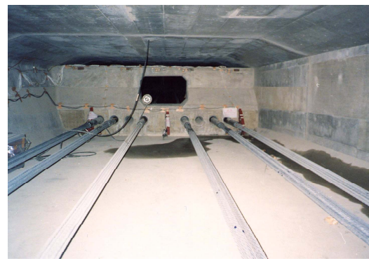
写真-1 上り線:セメントグラウト工法(左)と下り線:エポキシ樹脂被覆鋼材(右) (建設時撮影)
