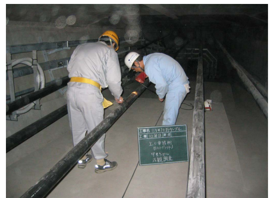
写真-3 外観調査状況 (上)下り線:エポキシ樹脂被覆鋼材 (下)上り線:セメントグラウト工法
