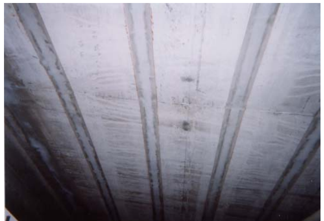
写真-3 陽極埋戻し完了時
