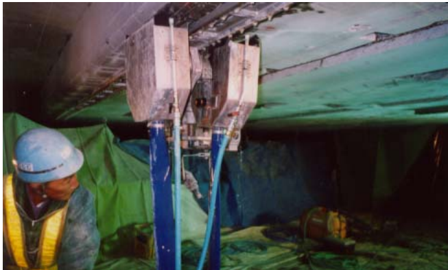
写真-1 陽極設置溝切削状況
