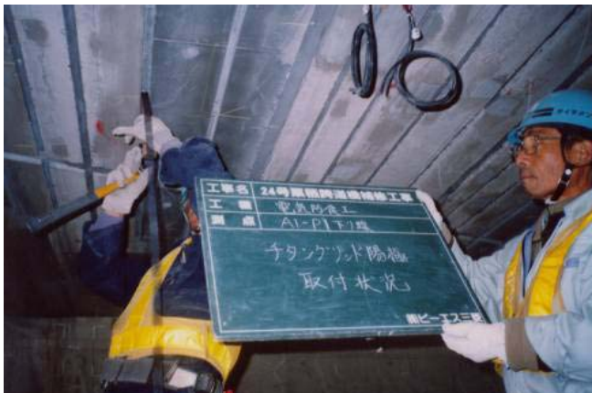
写真-2 陽極設置状況
