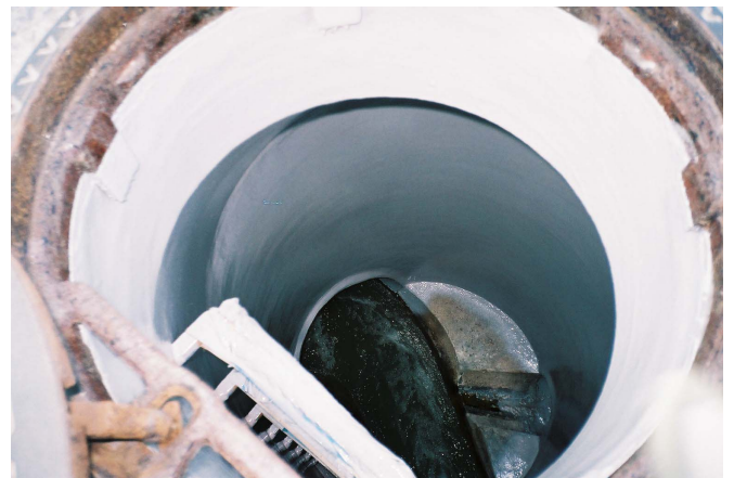
写真-2 工事完了
