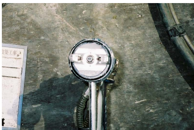
写真-12 専用吹き付け機先端
