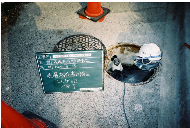
写真-4 表層劣化部除去状況
