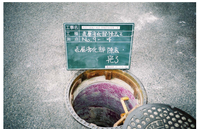
写真-5 劣化部調査状況
