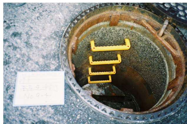
写真-3 予備洗浄完了
