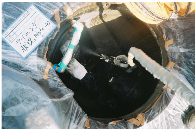
写真-9 ライニング吹き付け状況
