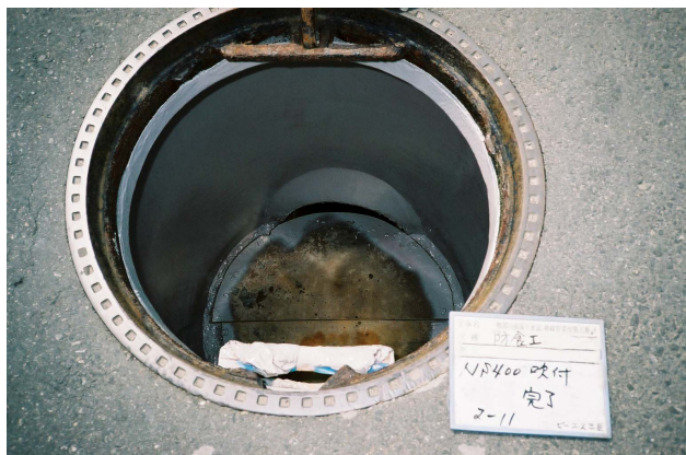
写真-10 ライニング吹き付け完了
