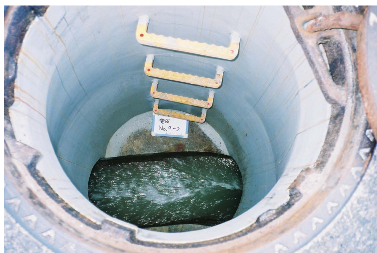
写真-15 施工完了
