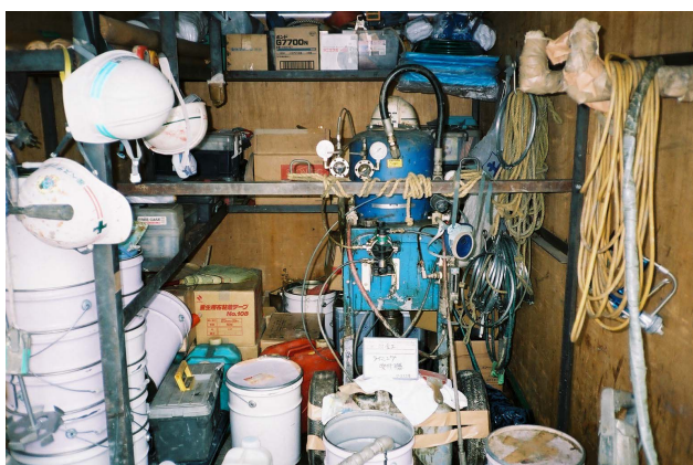
写真-11 専用吹き付け機本体
