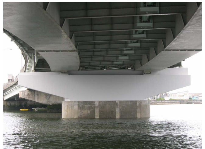
写真-2 施工後の状況
