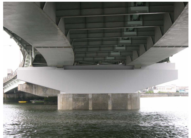
写真-2 施工後の状況
