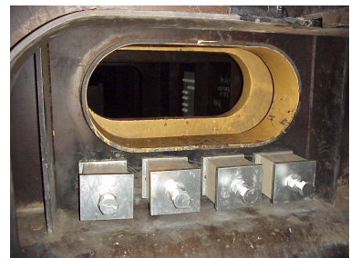
写真-4 新荒川大橋の 3DSole 弾性連結装置
