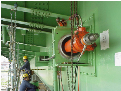
写真-3 扇大橋の PC 連結ケーブル
