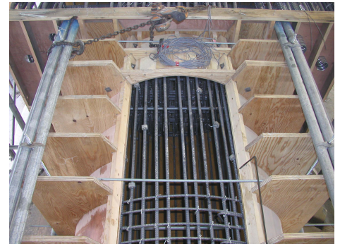
写真-9 付け根部配筋(C1, C2 模型)
