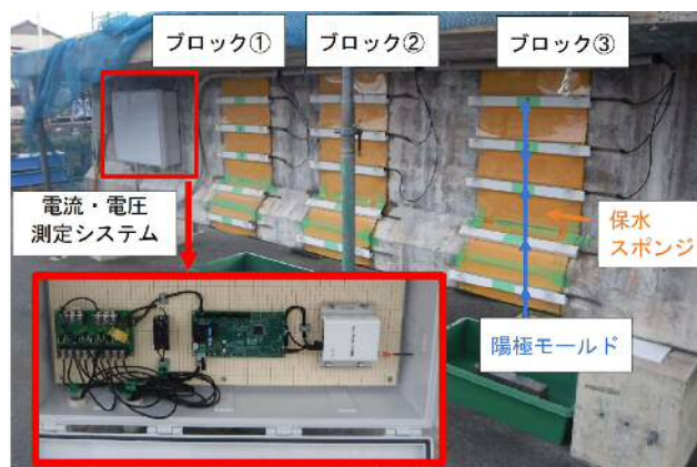
写真-2 電流・電圧測定システムと通電試験の状況
