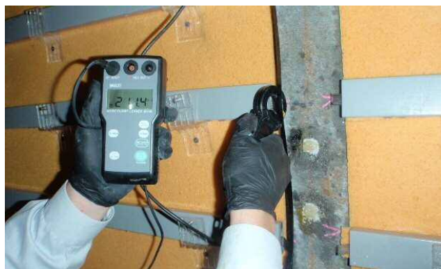
写真-1 クランプメータを用いた電流の測定状況
