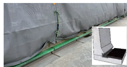
写真-2 モルタル製排水溝の施工状況
