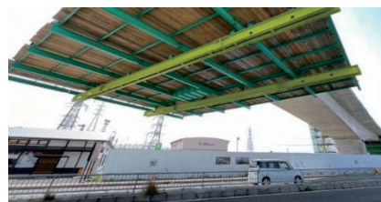
写真-1 最下段横梁の改造
