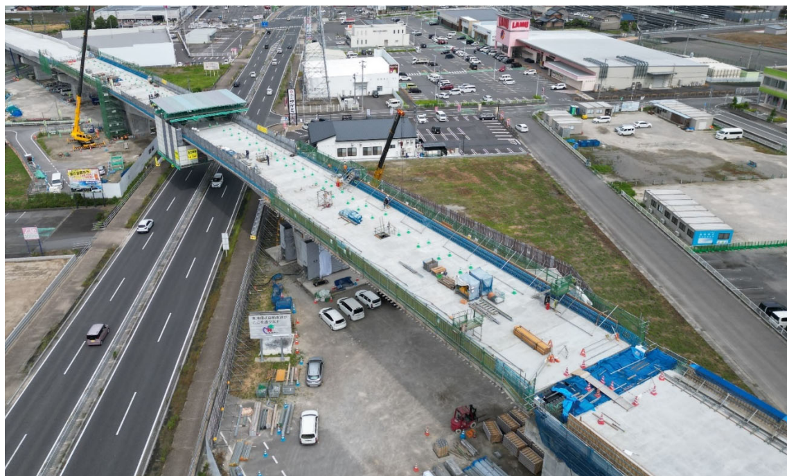
写真-8 全景写真（中央閉合部の施工状況）
