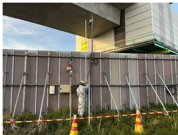
写真-4 レーザーバリアの設置状況
