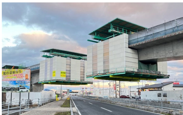
写真-1 幹線道路上の張出し施工状況
