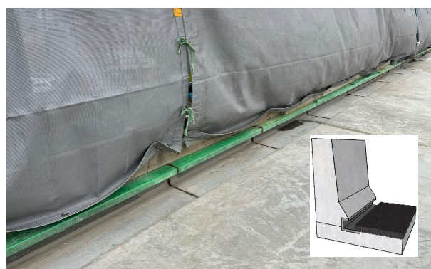
写真-7 モルタル製排水溝の施工状況
