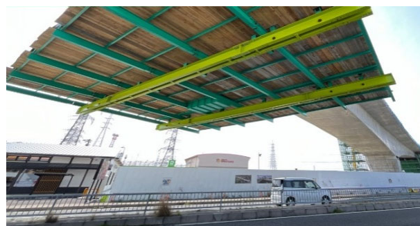
写真-3 最下段横梁の塗装
