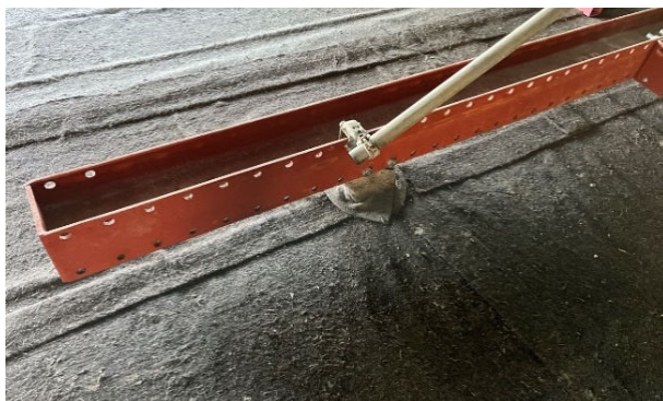
写真-5 下段作業台の防水シート
