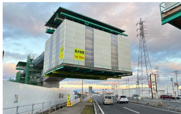
写真-2 幹線道路上の張出し施工状況 (近接写真)
