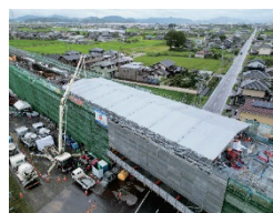
写真-1 屋根・シート
