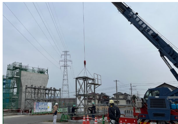
写真-3 支柱のユニット化
