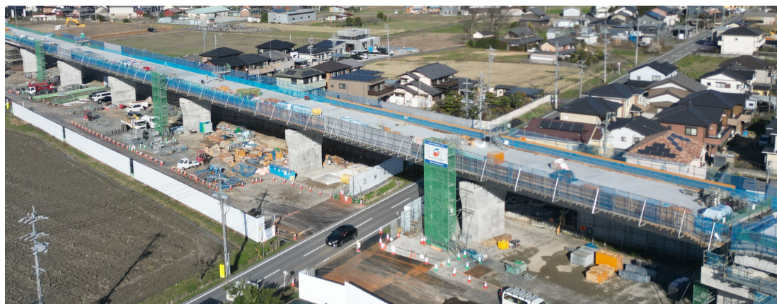
写真-4 施工写真
