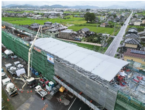
写真-1 屋根・シート設置
