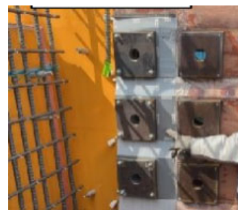
写真-3 型枠設置状況
