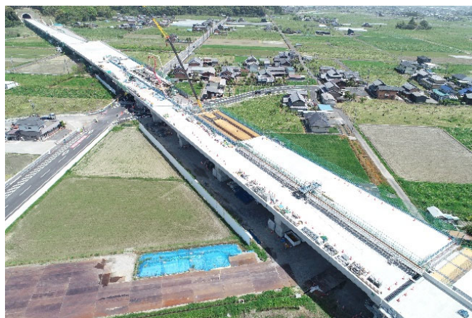
写真-4 工事状況写真
