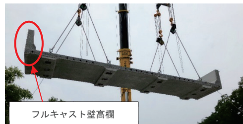
写真-1 プレキャスト PC 床版の架設状況
