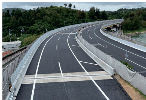
写真-2 規制解除前の全景 (A1 側より)
