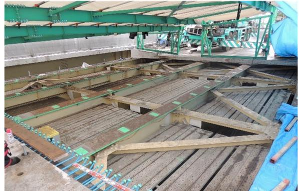
写真-5 雨天対応屋根設備の設置状況
