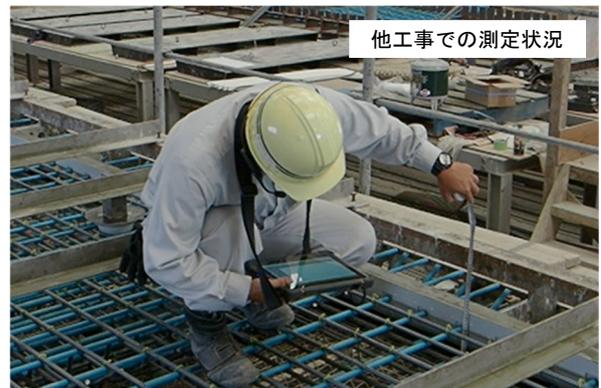
写真-2 出来形検測効率化システムの適用状況
