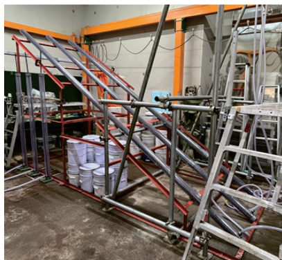
写真-1 試験体設置状況
