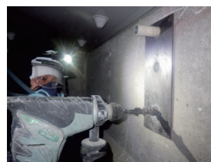
写真-1 アンカー削孔
