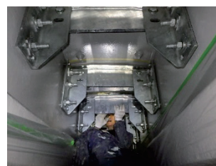
写真-2 T形リブ取付け
