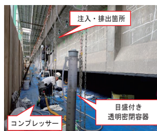
写真-2 補修材充填状況
