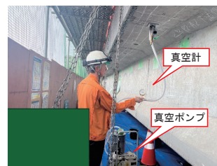
写真-1 通気確認状況
