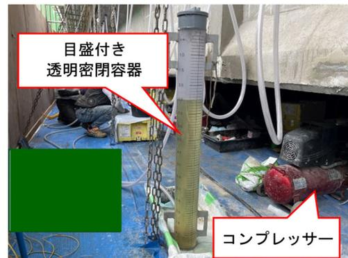
図-4 途中閉塞検知型低圧ポンプシステム
