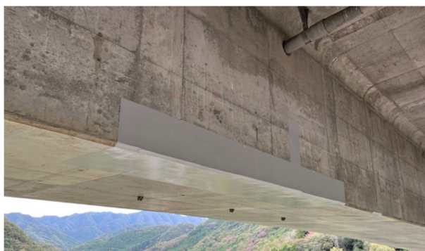
写真-4 補修完了後（下り線）
