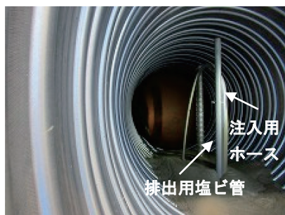
写真-2 無収縮モルタル注入状況
