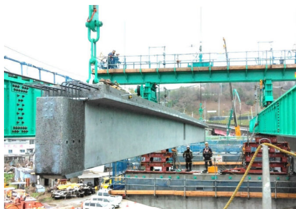
写真-2 部材架設状況
