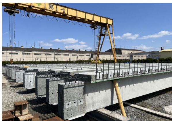
写真-1 部材保管状況
