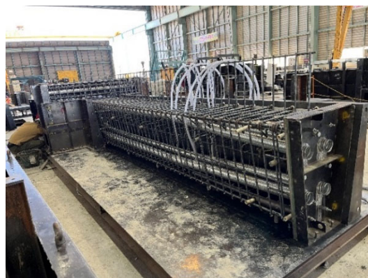
写真-2 PCa 部材製作状況
