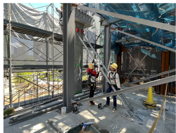
写真-9 PCa 部材建方調整状況
