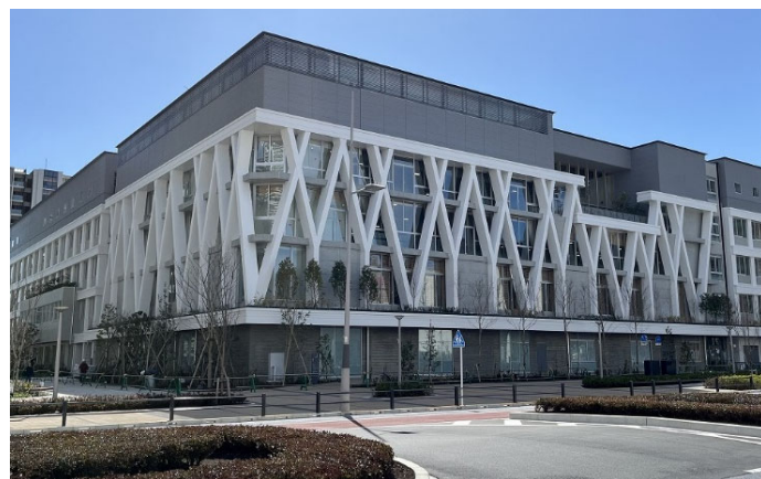
写真-1 建物外観
