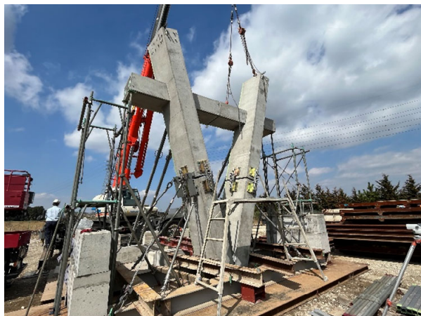
写真-8 試験施工状況
