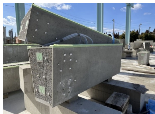
写真-3 PCa 部材出来形状況
