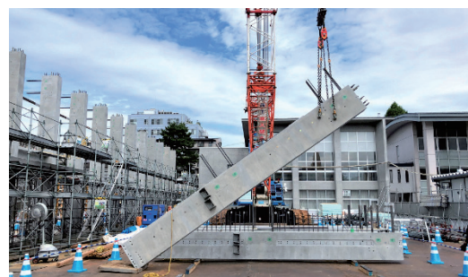
写真-2 PCa 柱建て起こし状況
