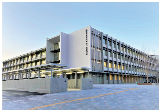
写真-1 建物外観（南東側）
