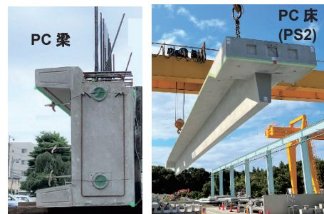
写真-3 PCa 部材（梁・床）
