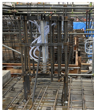
写真-7 柱主筋取付状況
