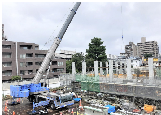
写真-5 250t クレーン架設状況
