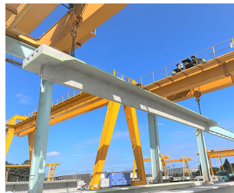
写真-4 PS2 工場検査状況
