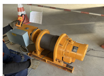
写真-18 PC 鋼より線通線状況
