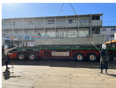
写真-8 柱揚重状況（仮置き）
