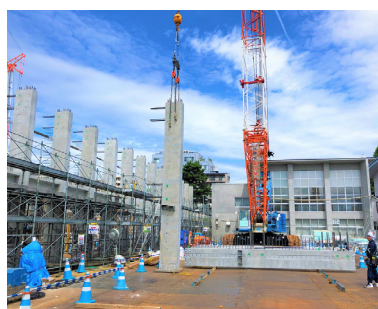
写真-9 柱建て起こし状況
