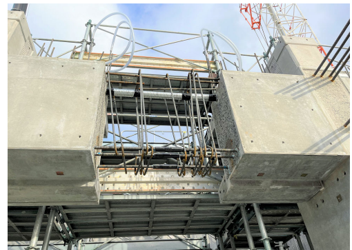
写真-2 接合部状況 (分割位置)
