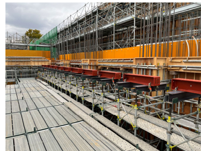
写真-15 PS2 支承部状況
