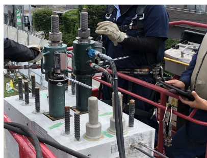
写真-16 PC 鋼棒緊張状況
