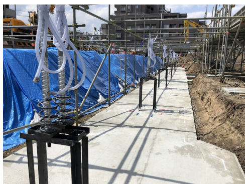
写真-6 アンカーフレーム設置状況
