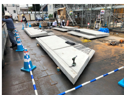
写真-12 庇仮置き状況
