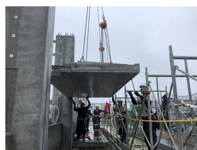
写真-13 庇架設状況
