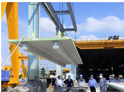
写真-3 PS1 工場検査状況
