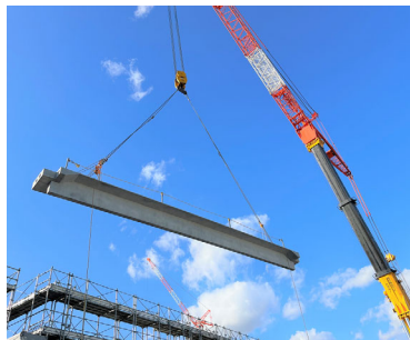
写真-14 PS2 揚重状況
