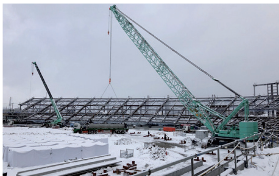
写真-3 施工時現場状況
