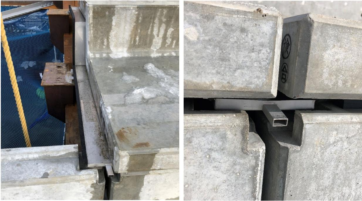
写真-3 SUS 排水樋 (PCaPC 段床板架設後)
