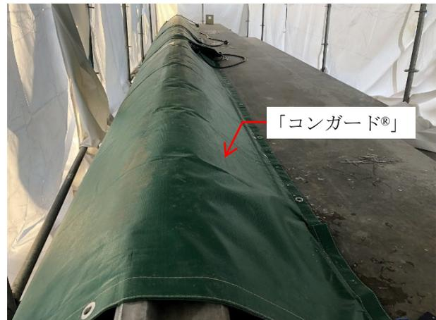
写真-8 養生上屋内での前養生状況
