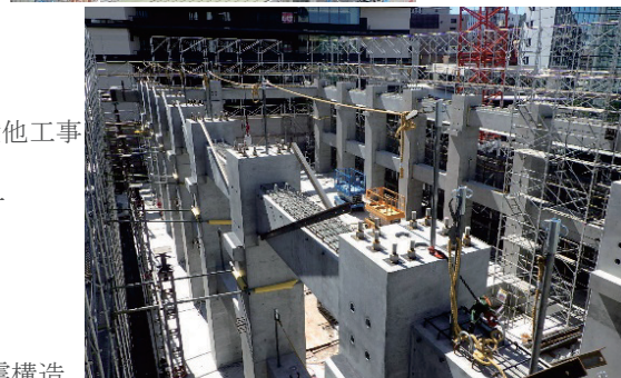
写真-2 2 層 1 柱の PCaPC 柱の施工状況
