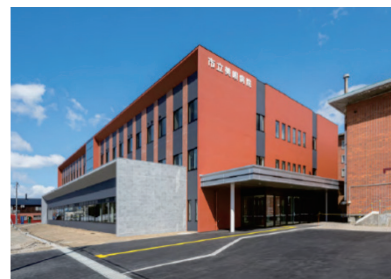
写真-1 建物外観
