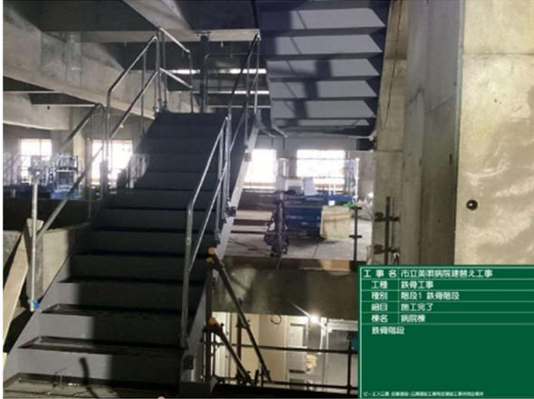
写真-3 鉄骨階段施工状況
