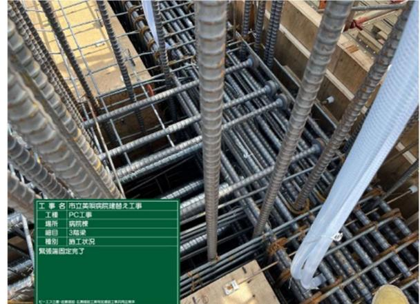
写真-4 PC梁定着部鉄筋組立状況
