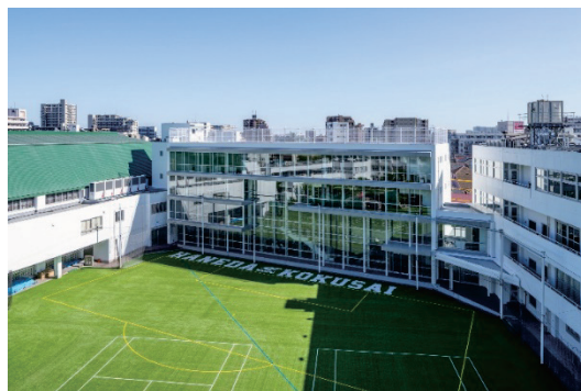
写真-1 建物外観
