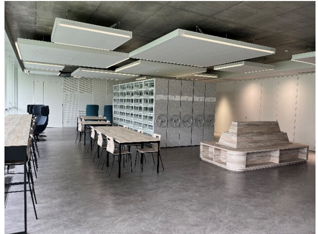
写真-9 吊り天井施工完了
