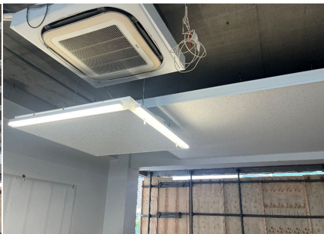
写真-7 モックアップ完成品
