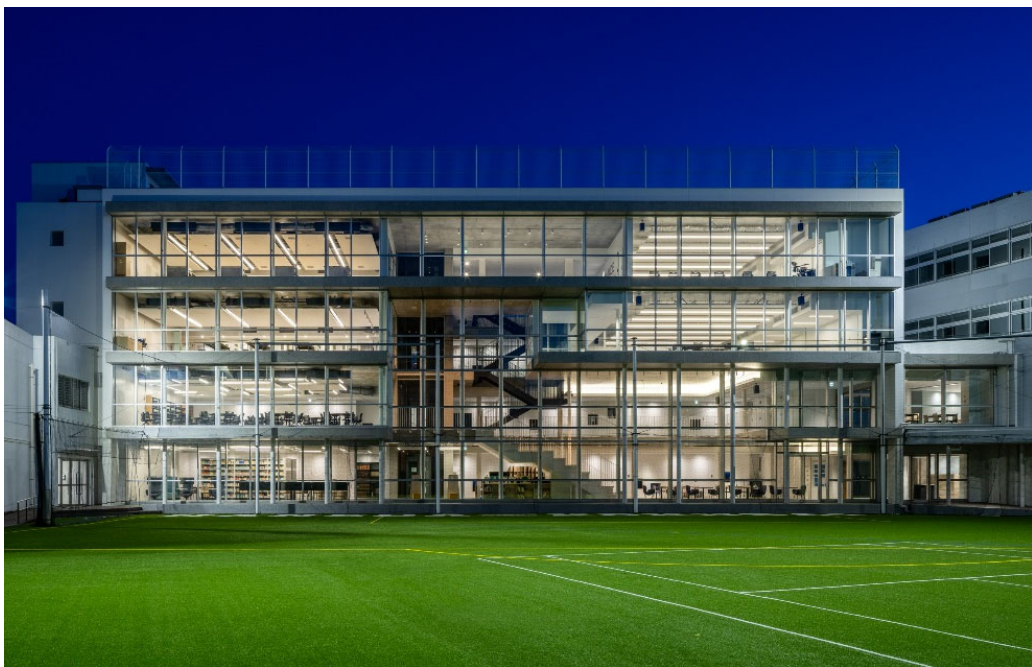
写真-1 建物外観（グラウンドより）
