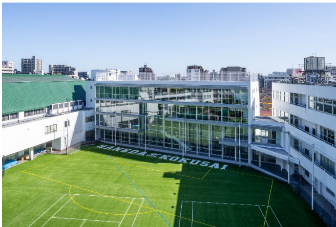
写真-10 北面外観
