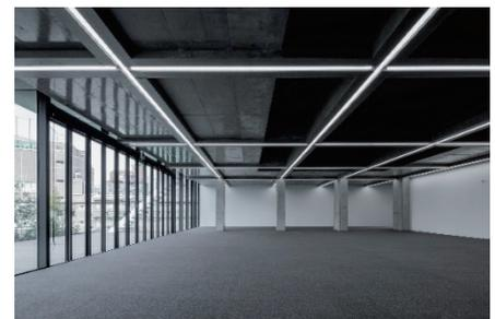
写真-2 天井打放し仕上げ状況
