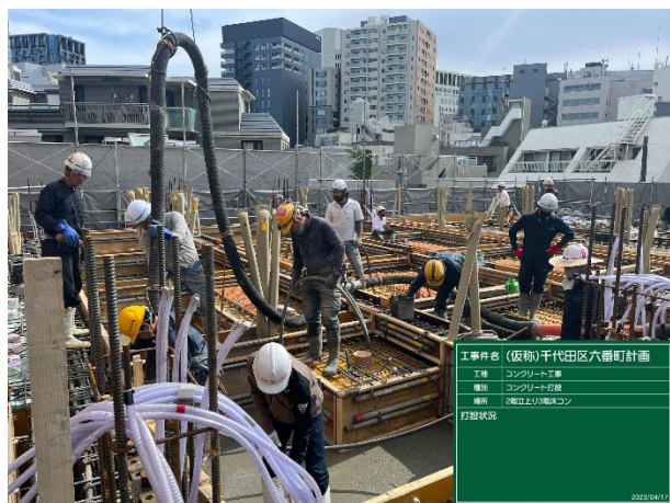
写真-8 コンクリート打設状況
