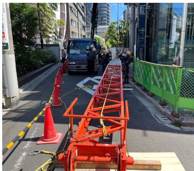
写真-7 タワークレーン解体状況
