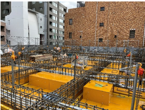
写真-4 配筋・PC 鋼線配線状況
