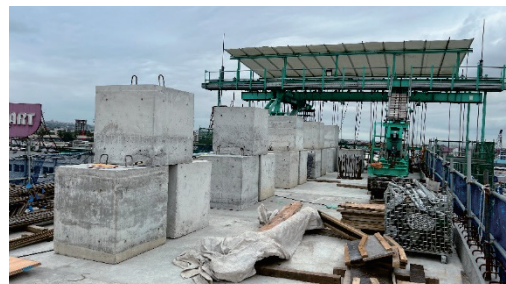
写真-2 カウンターウエイト載荷状況
