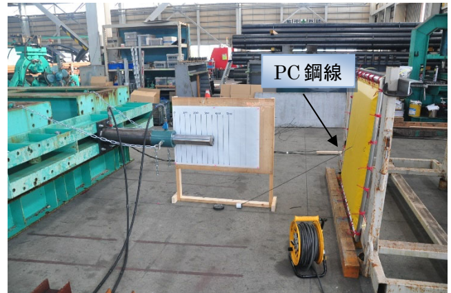
写真-5 PC 鋼線破断状況 2
