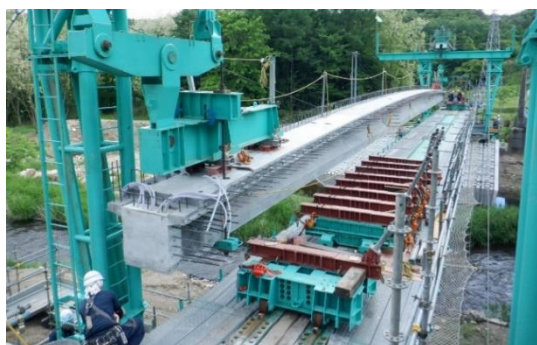
写真-1 主桁架設状況
