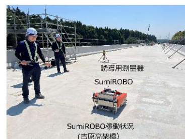
写真-7 SumiROBO 使用状況
