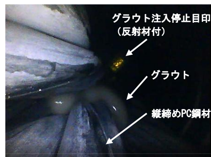
写真-1 超小型カメラ目視確認
