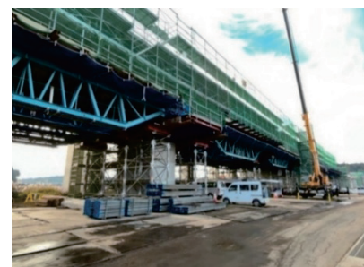
写真-1 支保工状況
