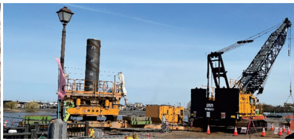
写真-2 掘削の状況
