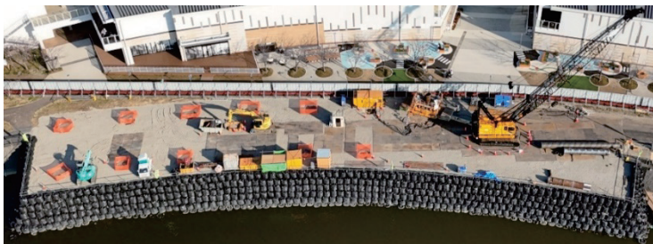
写真-1 施工の全景
